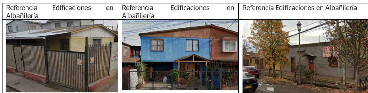
Ilustración 1-87 Tipologías referencia Material en Albañilería Paine Centro
